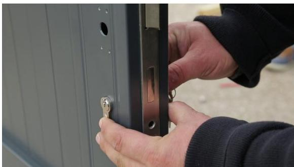
**12.** Installez la serrure sur le vantail et fixez-la à l'aide des vis. Faites de même avec la poignée.
