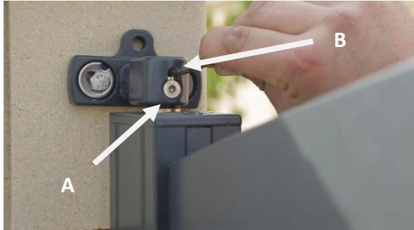
**8.** Si ce n'est pas le cas, utilisez la vis A sur les gonds pour régler cet alignement (ne pas oublier de bloquer la contre-vis B, au dessus de la vis centrale).
